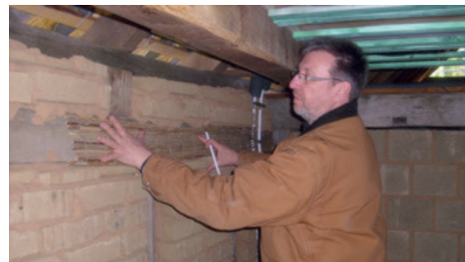
Das Schilfrohr auf den Balken dient als Putzträger. Früher verwendete man stattdessen Weiden- oder Haselruten, die man mit kleinen handgeschmiedeten Nägeln und Strohrefen festnagelte.
