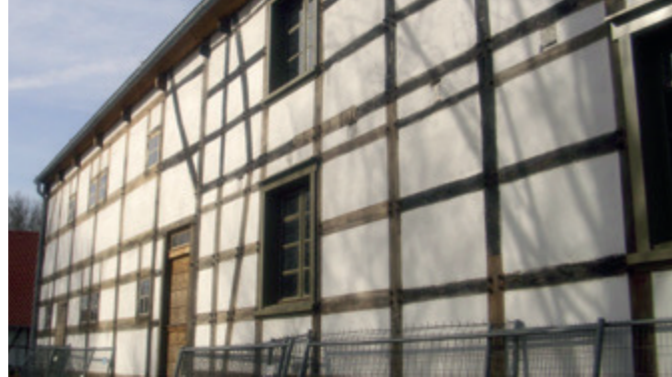
Haus Dahl, aus der Nähe von Wülfrath, wurde in den Jahren 2010 – 2011 transloziert. Die Firma NaturBauKonzepte hat eine Hälfte des Gebäudes neu gezimmert, das Außenfachwerk und den Dachstuhl komplett erneuert. Das Gebäude wurde ausgefacht, von innen und außen verputzt und mit Sumpfkalk geweißelt.
