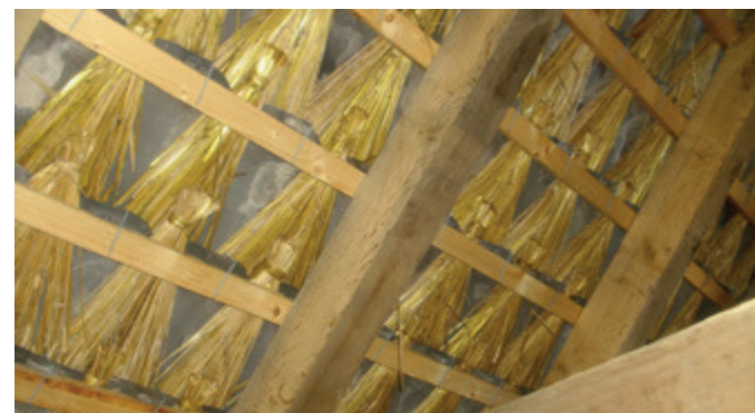
Die Dachhohlpannen werden mit Strohdoggen ausgepolstert.
